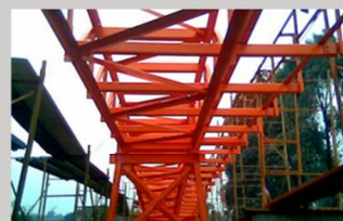
PORTUARIA CABO FROWARD Aplicación de Pintura
